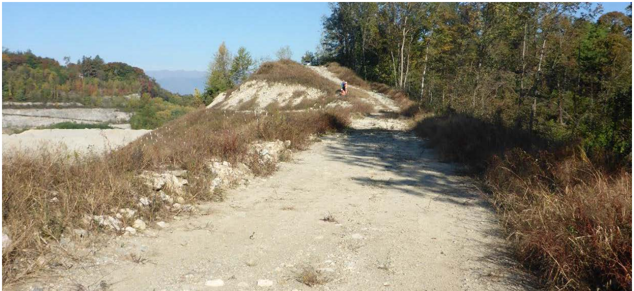
Figura 2.2 – Pista di cantiere lungo il fronte est posta a q. 320 m s.m. Inquadratura verso nord
