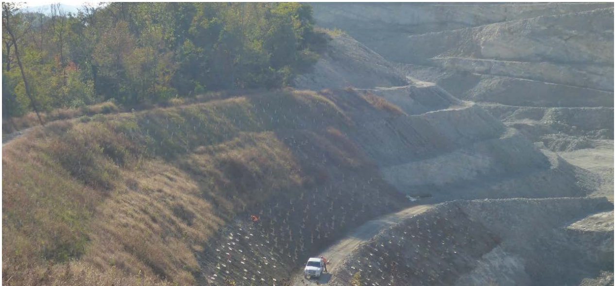
Figura 2.1 – Recupero morfologico del fronte est. Piantumazione lungo i rinfianchi
